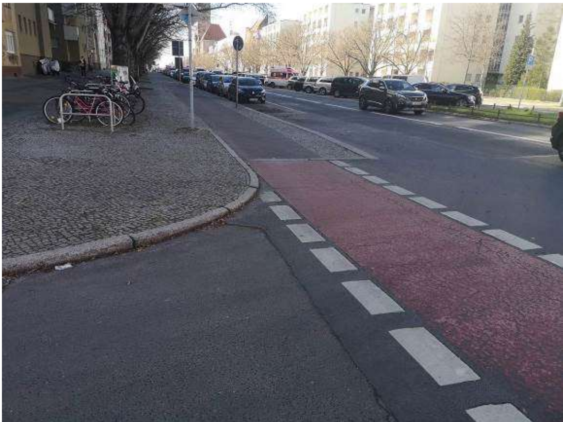
An Kreuzungen sollten die Radwege farblich markiert und deutlich erkennbar sein © MoBild
