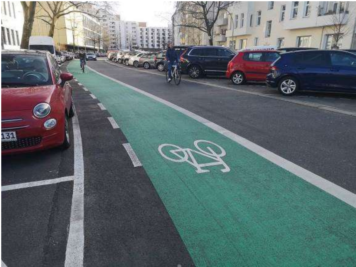
Ein Radfahrstreifen mit durchgezogener Linie © MoBild
