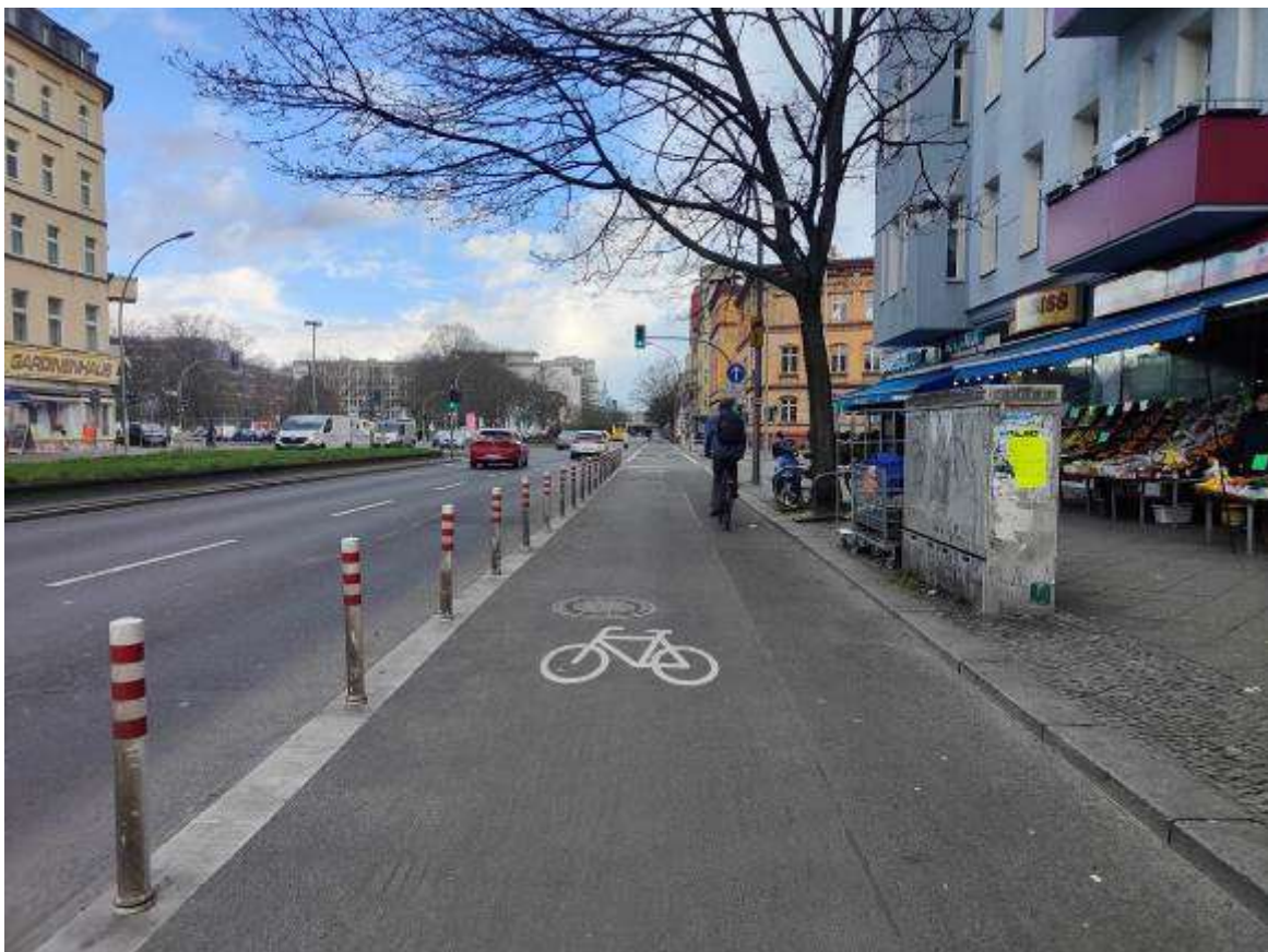
Ein mit Pollern geschützter Radfahrstreifen © MoBild
