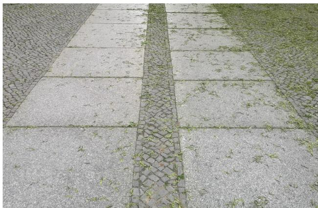
Abb. 29. Typische Berliner Pflasterung aus Granitplatten und Kopfsteinpflaster (© MoBild)
